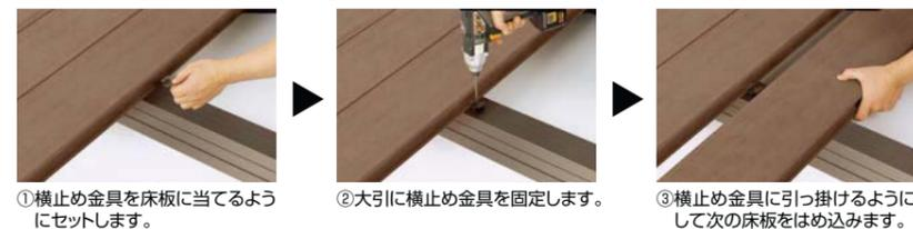
横止め専用の金具で床板同士を連結する方法です。床板のすきまが均一に施工でき、また外観から金具やネジが見えないので、美しいデッキの仕上がりになります。
